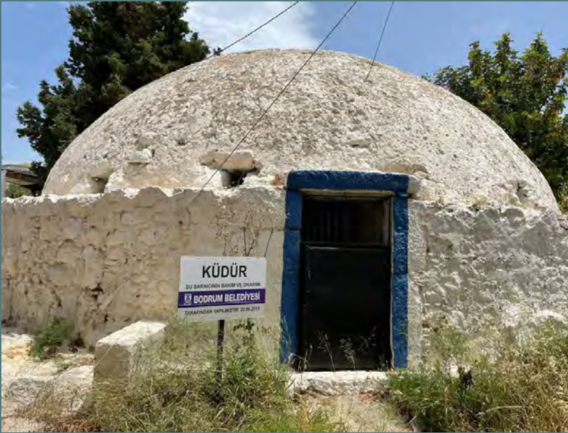
Haziran 2022'de bir Sarnıç A cistern in June 2022
